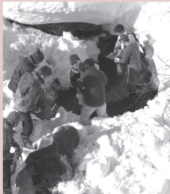
▲1メートルを超える積雪と水温0.5度の中、作業を行いました
