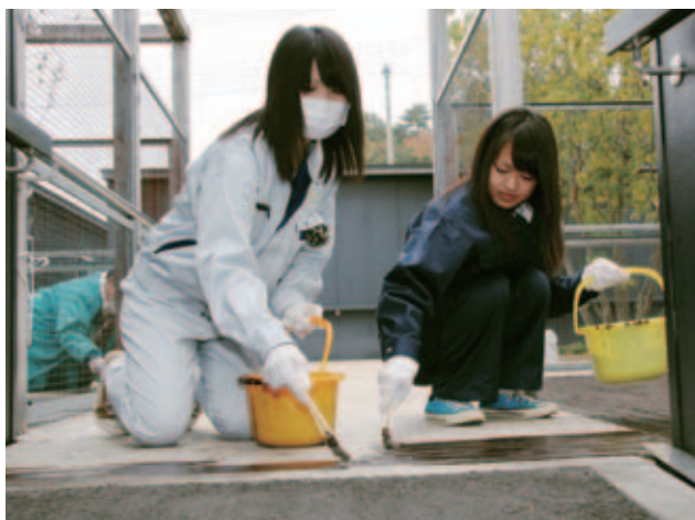
▲一生懸命作業を行う白石工高建築科の生徒たち
