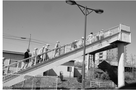
橋梁長命化対策事業(白石駅歩道橋)
