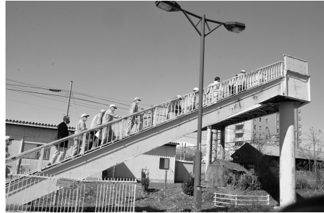
橋梁長命化対策事業(白石駅歩道橋)
