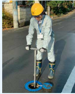
▲仕切弁を操作している職員
