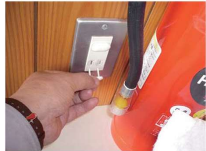
写真2：コンセントを使用不可にする方法例
