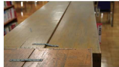
写真2: 棚同士の連結による固定の例
