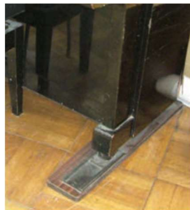
写真3：アップライトピアノの転倒防止対策
