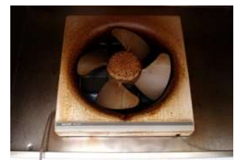
写真2：著しく汚れた換気扇
