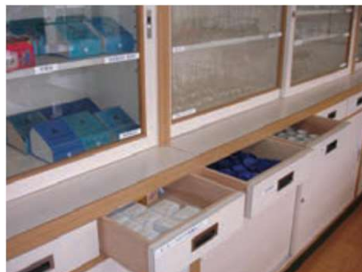
写真2：振動により開いた引き出しの例
