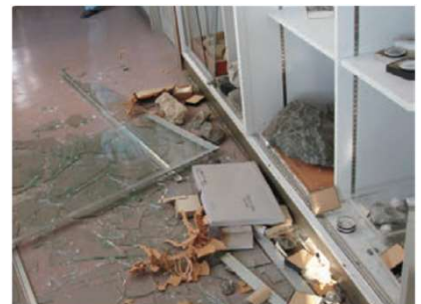
写真3：収納物が飛び出しガラスが飛散した例
