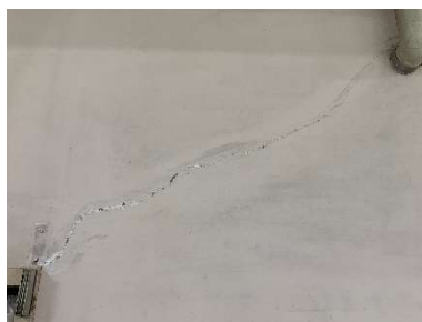
写真2：内壁のひび
