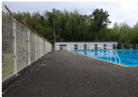
写真1：プールサイド・フェンス
