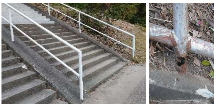
写真1：鉄製の手すり
