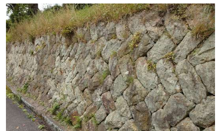
写真1：敷地内の擁壁
