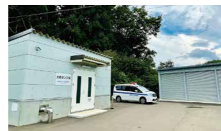
▲大町ポンプ場と備蓄倉庫
