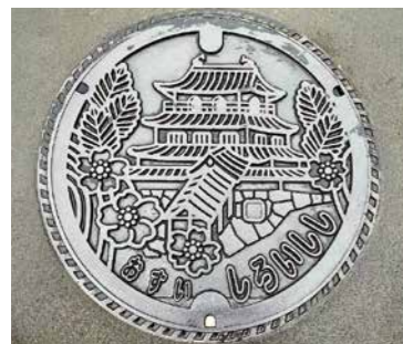
▲更新したマンホールのふた
