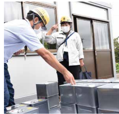
▲総合福祉センターの屋根防水改修工事で使用する材料の仕様確認
