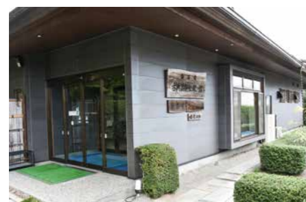
▲地震による被害から復旧した古典芸能伝承の館「碧水園」【災害復旧費】
