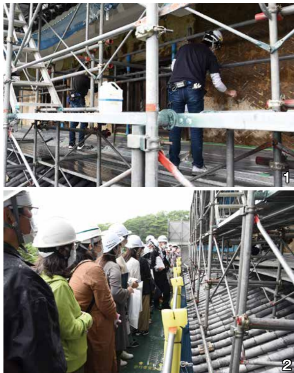
1_天守閣2階のしっくい壁を補修する作業員 2_補修作業の様子に真剣なまなざしを向ける参加者
