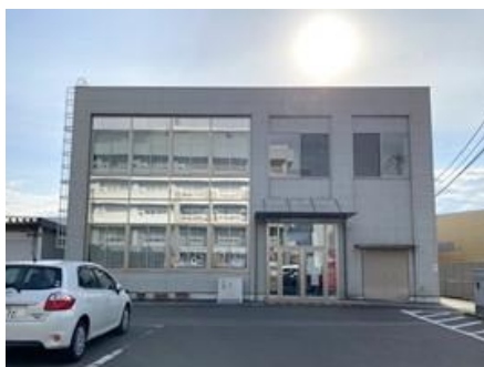
防災センター
