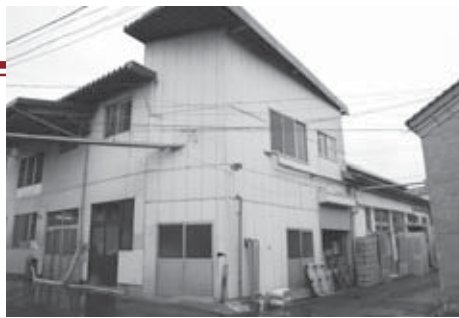
◀1日の生乳処理量は15t、365日フル稼働という同社の工場
