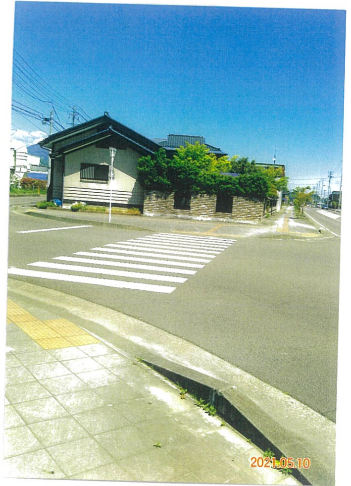
中央公民館入口付近
