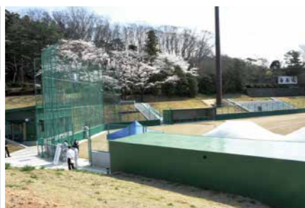
▲全面改修され4月から利用を開始した益岡公園野球場【土木費】
