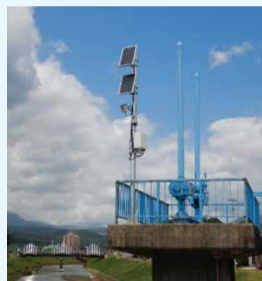
▲簡易型河川監視カメラ 設置例 (斎川 鷹巣西一丁目地内)
