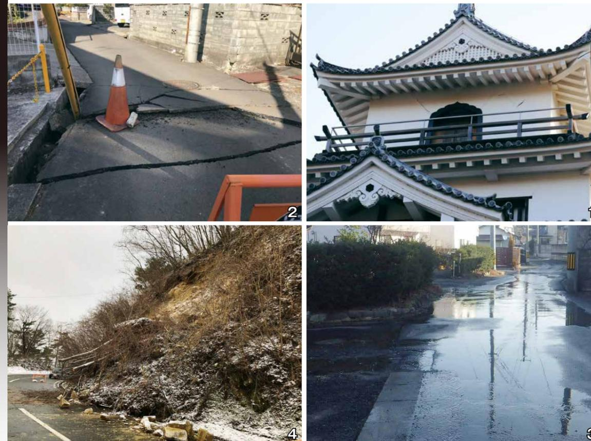
1\_白石城や大手二ノ門、一ノ門、土塀の漆喰壁などに多数のひびやはがれを確認 2\_市道南寺前2号線の被害状況 3\_配水管の破損により漏水し、道路が水浸しに 4\_落石により一時通行止めになった市道川原子線。現在も片側交互通行となっています
