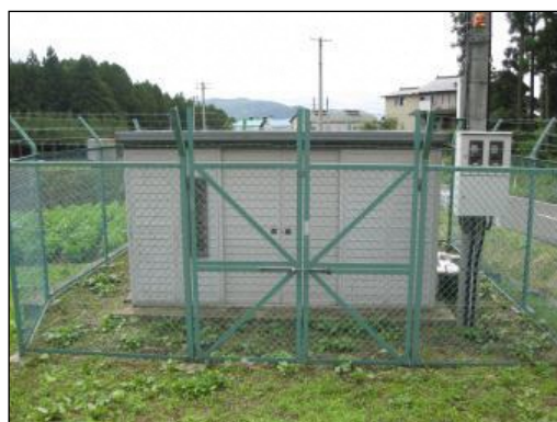
八森ポンプ場外観①
