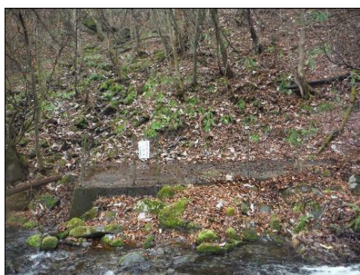
二ツ森水源外観
