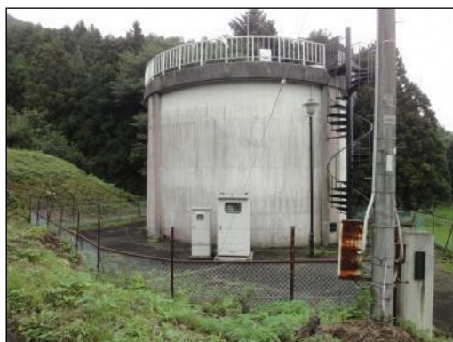
大石原配水池外観
