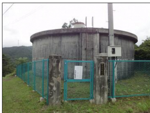
弥治郎配水池外観
