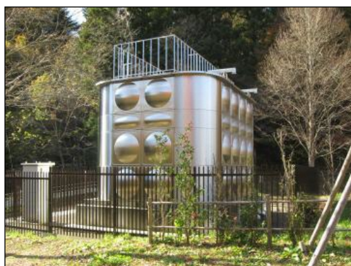
湯元配水池外観
