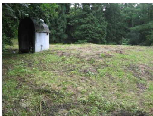
愛宕山第1配水池(休止中)
