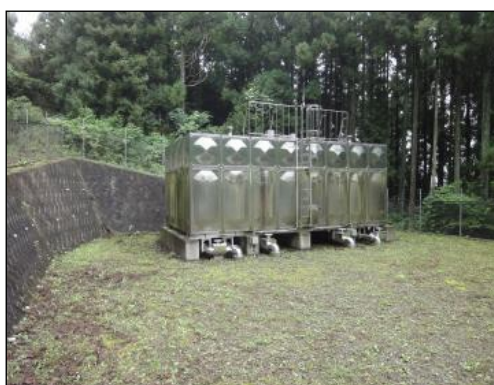
上森合配水池外観
