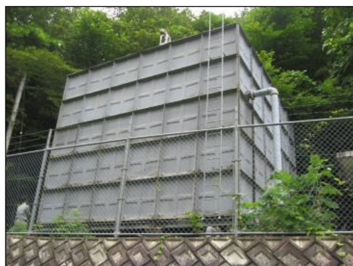
越河平配水池外観
