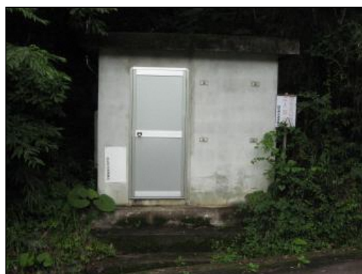
郡山ポンプ場外観
