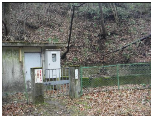
三住水源及びポンプ場外観
