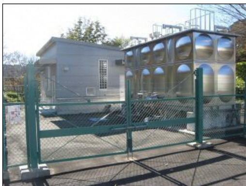
湯元ポンプ場外観
