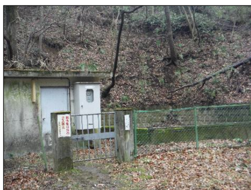
三住水源及びポンプ場外観
