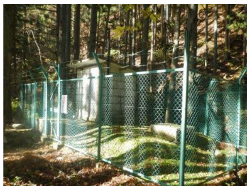
上戸沢配水池外観
