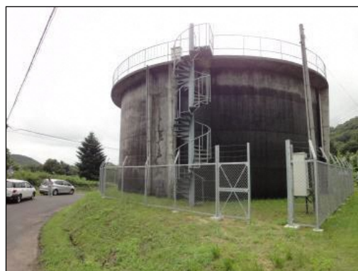
八宮配水池外観
