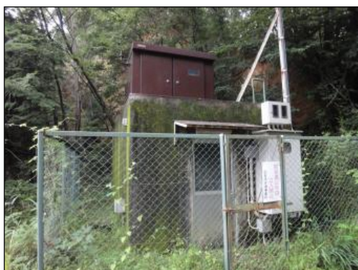
宇当坂ポンプ場外観
