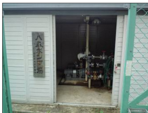
八森ポンプ場外観②
