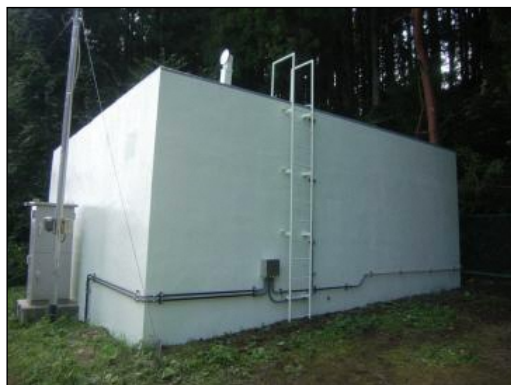
二ノ萱配水池外観
