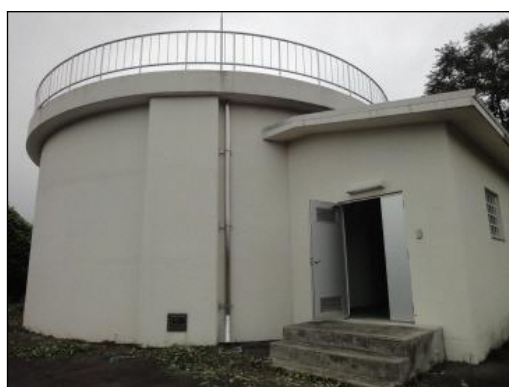
灰坂配水池外観
