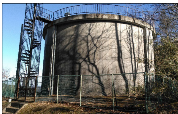
割山配水池外観
