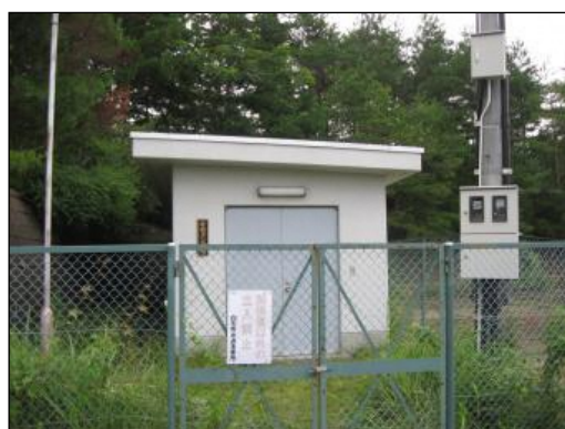
若林ポンプ外観
