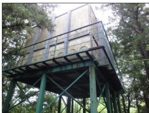
若林配水池外観
