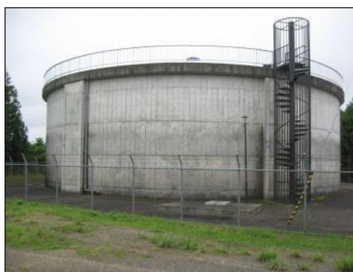
鷹巣配水池外観
