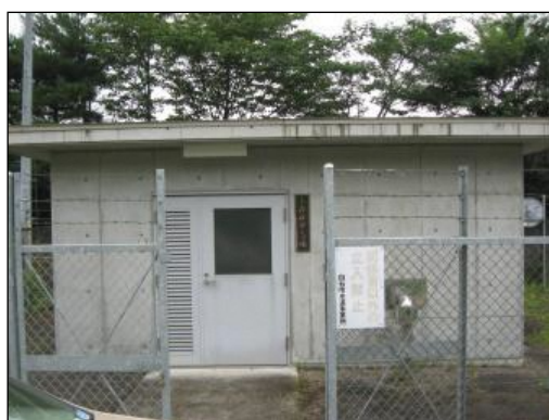
上森合ポンプ場外観
