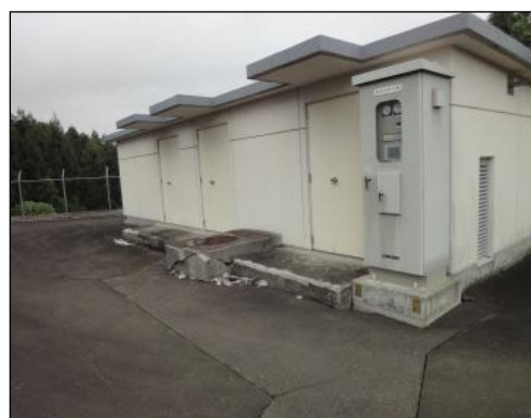
機械電気室外観
