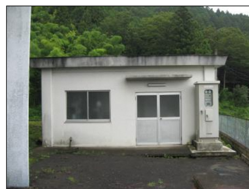
機械電気室外観
