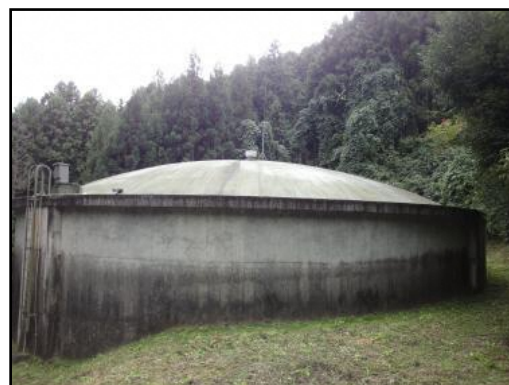
愛宕山第2配水池外観
