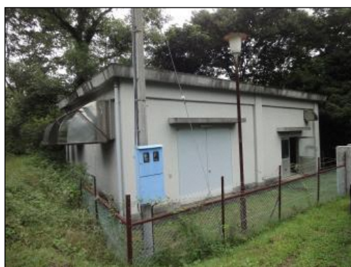
南台ポンプ場外観
