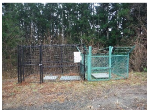
下戸沢着水井外観
