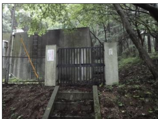
小野作配水池外観
