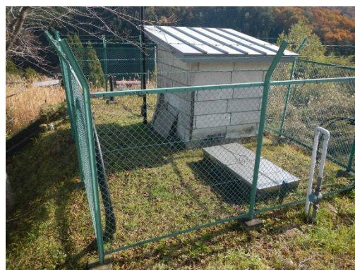
下戸沢配水池
