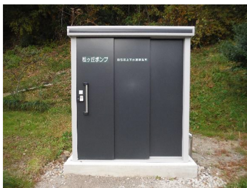
松ヶ丘ポンプ場外観
