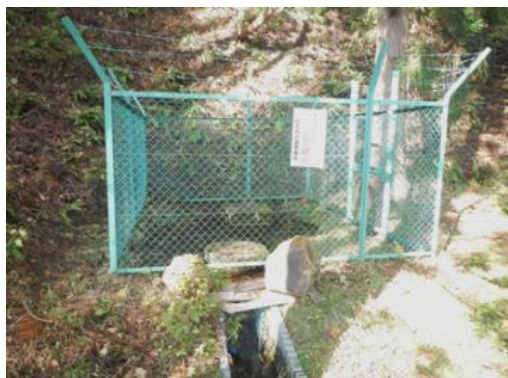
上戸沢水源外観
