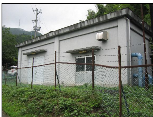
斎川第1ポンプ場
