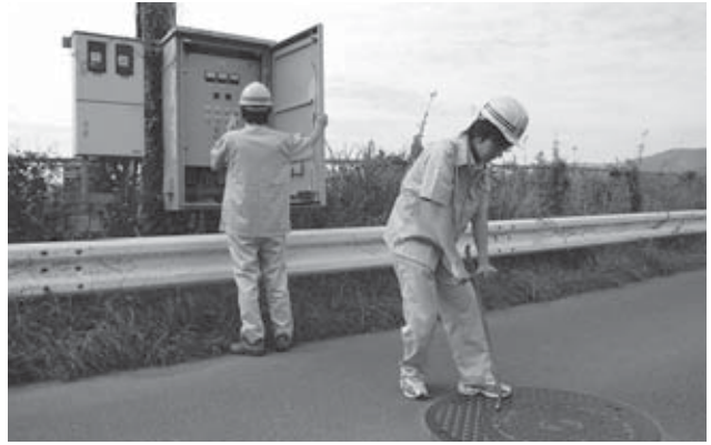
▲マンホールポンプ施設を点検する職員
