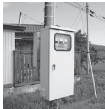
▲マンホールポンプ施設には、必ず配電盤が設置されています
