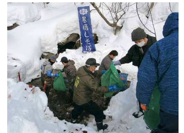
▲分厚い雪で覆われた溪流。冷たさをこらえての作業
