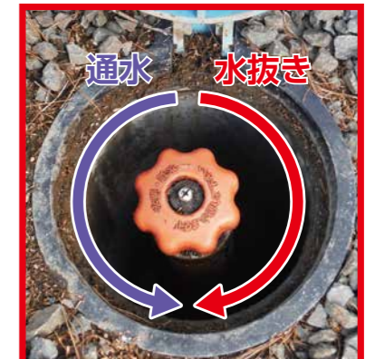
▲屋外に設置してある水抜栓。いろいろな種類・設置場所があります
