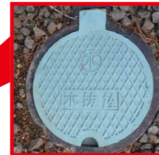
▲屋外に設置してある水抜栓。いろいろな種類・設置場所があります
