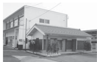
▲駅舎南側に完成したトイレ
