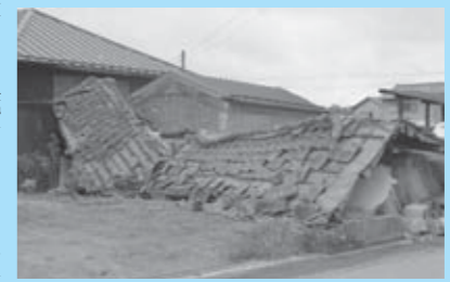
▲地震により倒壊した家屋
