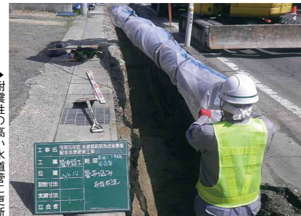
▶耐震性の高い水道管に更新
