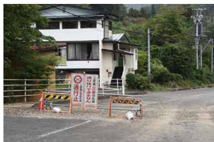
▲令和元年東日本台風では道路や農地に多大な被害が発生【災害復旧費】
