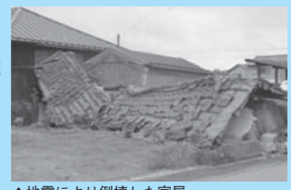
▲地震により倒壊した家屋
