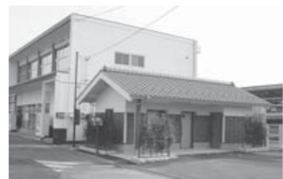
▲駅舎南側に完成したトイレ
