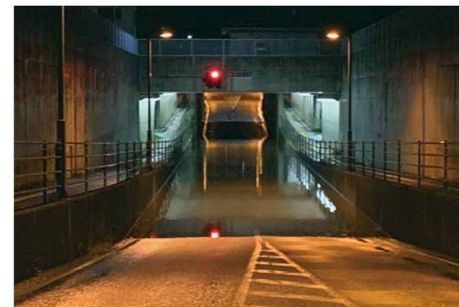
▲冠水した国道113号白石トンネルのアンダーパス
