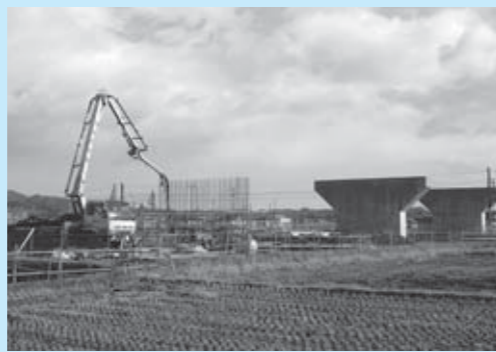
▲順調に工事が進む都市計画道路「沖の沢郡山線」
