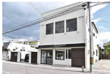
▲「109-one」の隣と小原地区の2カ所に、空き家を活用した2～9泊で生活体験ができる「移住体験住宅」も整備！
