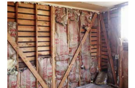
▲耐震補強中の壁
