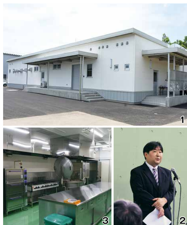
1_旧シリウスの跡地に建設されたみのりファクトリー 2_開所式であいさつをする佐々木代表理事 3_施設内にある野菜・果物の加工室
