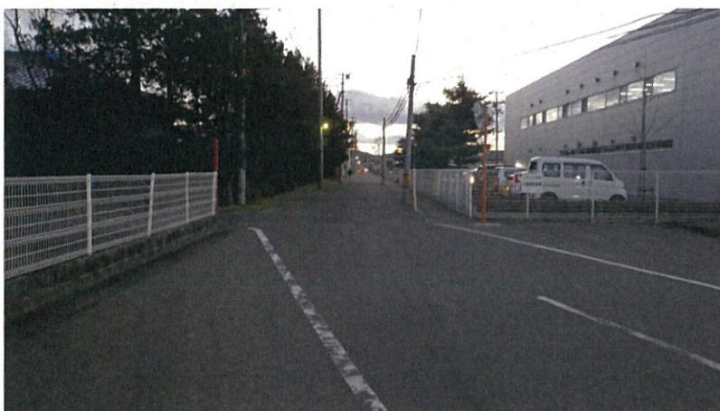
市道白石田中線 北側（トカドエンジン(株)付近）
