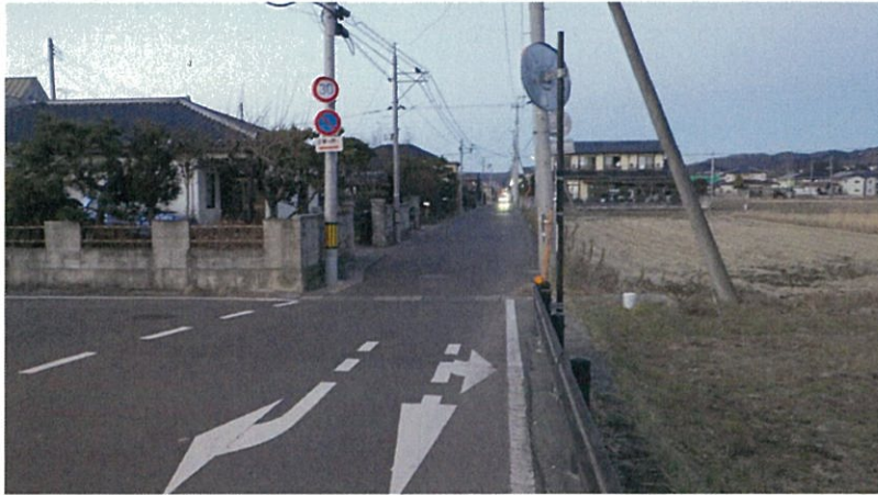
市道白石田中線 南側（市道との交差点付近）
