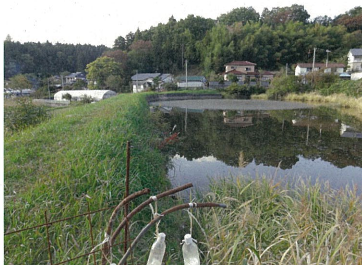
鷹巣奥ため池（道路奥 2つ目）
